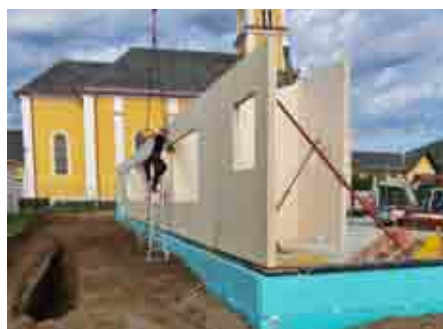
Aufstellung der ersten Wände
