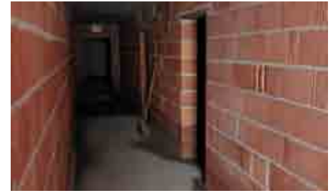
Ein Blick in den Keller
