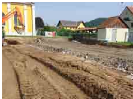
Grundierung bzw. Frostkoffer
