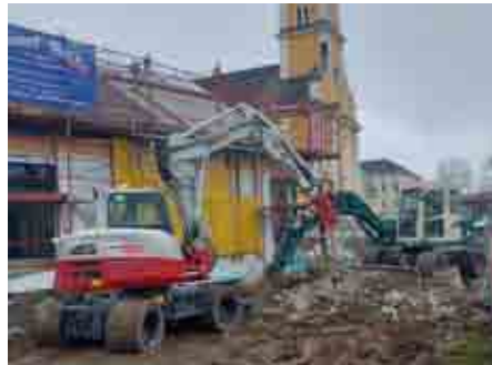
Abriss alte Trafostation
